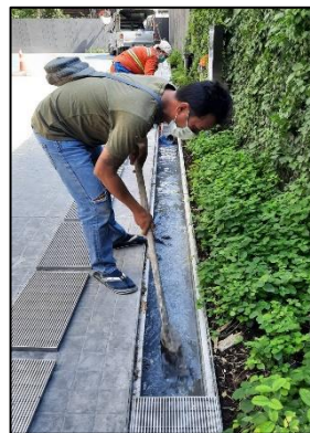
ภาพที่ 15 ขุดลอกดินตะกอนที่ตกค้างภายในท่อระบายน้ำ
