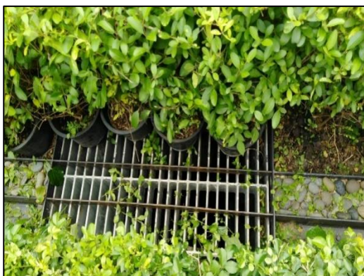
ภาพที่ 16 ตะแกรงดักขยะก่อนระบายน้ำออกจากโครงการ
