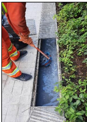
ภาพที่ 15 ขุดลอกดินตะกอนที่ตกค้างภายในท่อระบายน้ำ
