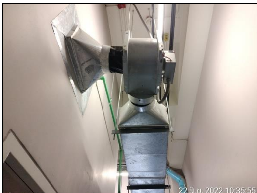
ภาพที่ 11 พัดลมดูดอากาศเสียภายในห้องพักขยะรวม และห้องพักขยะประจำแต่ละชั้น
